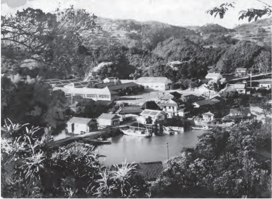
塩浜港（釜港、福島小学校も見える）
