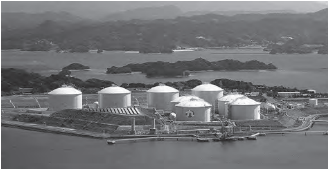
LPガス基地(九州液化瓦斯福島基地株式会社のHPより)
